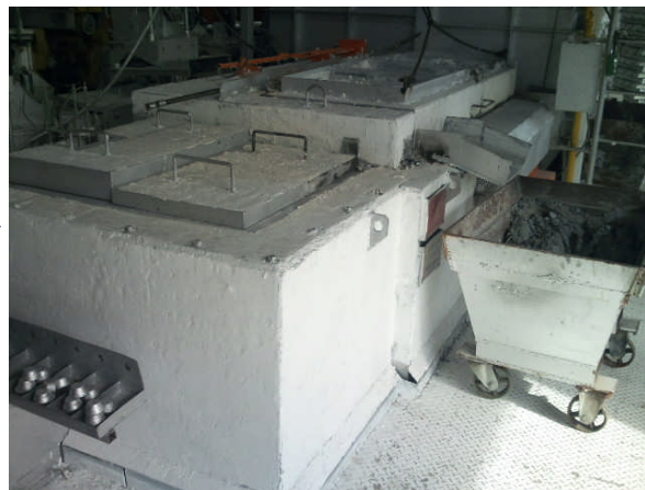
施工後 炉表面温度70°C
