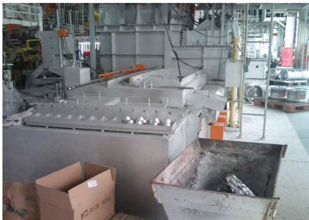
施工前 炉表面温度100°C
