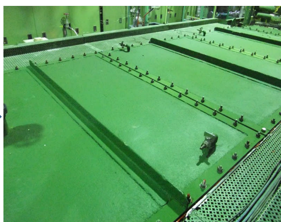
施工後 炉表面温度152°C
