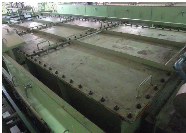
施工前 炉表面温度220°C
